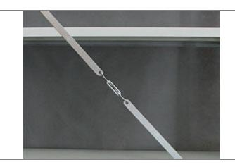
Соедините две растяжки талрепом и затяните его.
